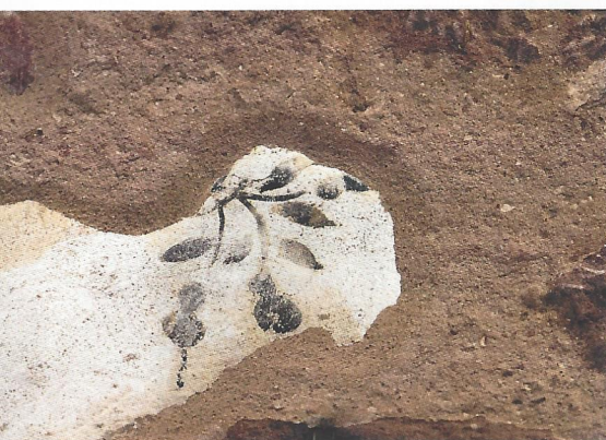
Abb. 20: An gefährdeten Stellen wird der Kalkputz mit einem Anböschmörtel gesichert
