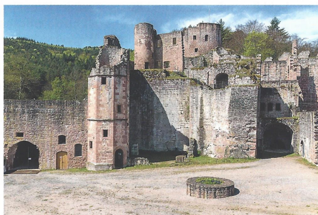
Abb. 2: Im Treppenturm der Hardenburg (links im Bild) wurden die historischen Putzflächen gesichert
