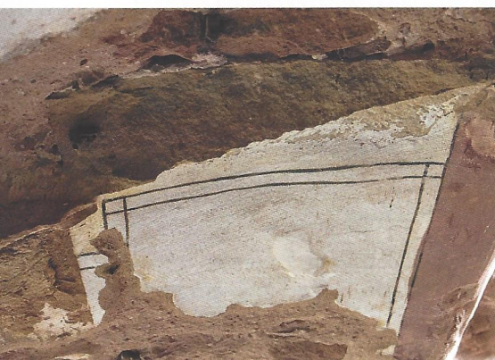
Abb. 19: Teilweise sind Malereien auf dem alten Kalkputz erhalten geblieben
