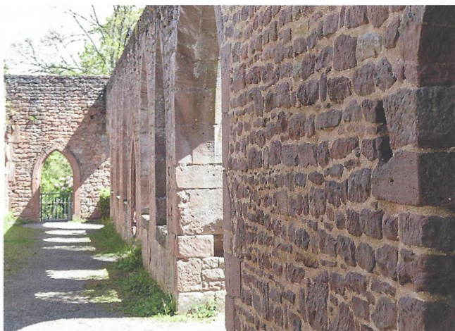
Abb. 23: Der Fugenmörtel erhält seine zum Buntsandstein passende Farbigkeit durch die Beigabe von roten und gelben Sanden
