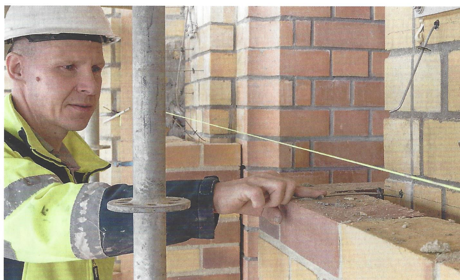
Abb. 5: Unter anderem biegsame Luftschtanker mit einer leicht flexibel angelegten Lagerung im Kernmauerwerk sorgen für die Anbindung der neu aufgemauerten Vorsatzschale. Hier demonstriert Andreas Schmidt von wibbeke denkmalpflege die Flexibilität der Luftschtanker.
