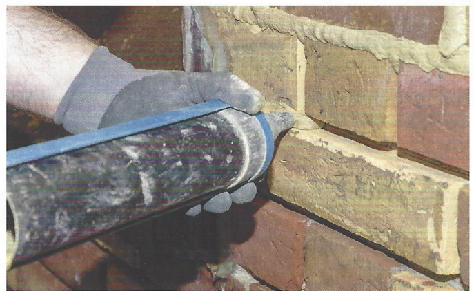
Abb. 3/4: Beim Verfugen war eine sorgfältige handwerkliche Verarbeitung für die angestrebte gute Flankenhaftung wichtig. Als Applikationstechnik wurde das Kartuschenverfahren gewählt, auf das der Mörtel abgestimmt wurde. So konnte eine homogen dichte Fuge von hinten nach vorne aufgebaut werden.
