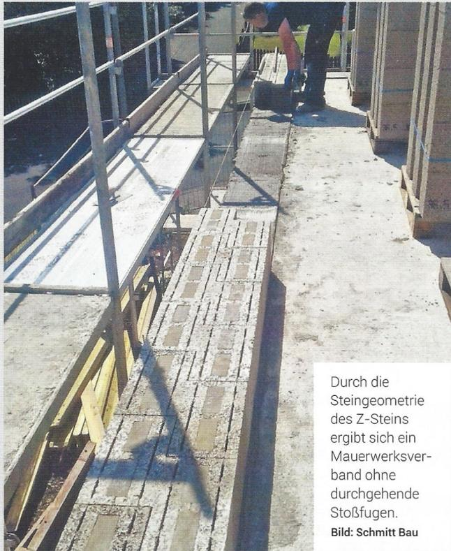
Durch die Steingeometrie des Z-Steins ergibt sich ein Mauerwerksverband ohne durchgehende Stoßfugen.
